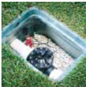
A PGV mágnesszelep minden változata alkalmas kézi működtetésre, miközben a szelepdoboz száraz és tiszta marad
